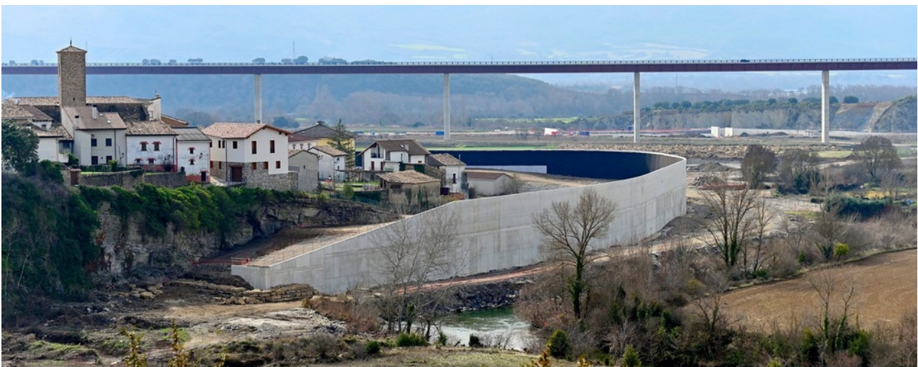
El muro que rodea Sigüés que se supone evitará la inundación del pueblo. Al fondo el viaducto de la autovía del Pirineo. Compartida por Antonio Aretxabala en Twitter.
